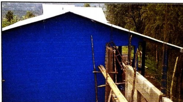
Foto 10: Instalación de láminas troqueladas en el corredor del establecimiento.
