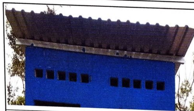
Foto 4: se evidencia la Instalacion de laminas troqueladas del baño
