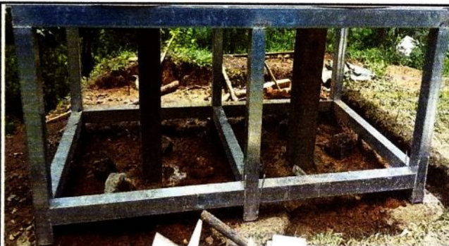
Foto 11: vista panorámica de la instalación de la estructura metálica de la base del tinaco.
