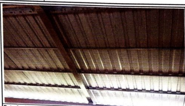
Foto 2: vista panoramica de la instalacion de laminas troqueladas y costaneras galvanizadas del establecimiento educativo de la comunidad.
