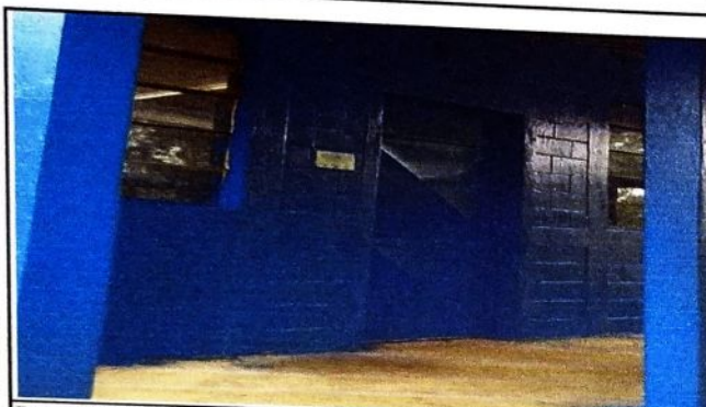
Foto 3: Posterior de haber realizados varios procesos de remodelacion se observa la instalacion de puerta de la escuela.
