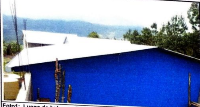
Foto 1: Luego de haber realizado los diferentes procesos de remodelación, se observa la instalación de laminas troqueladas del techo del establecimiento.
