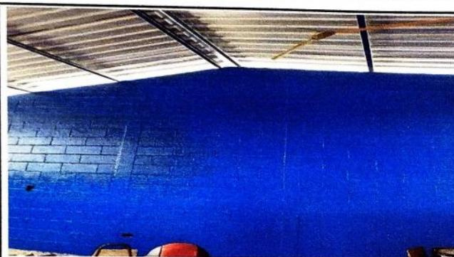
Foto 9: posterior de haber realizados varios procesos de remodelación se observa la colocación de pintura nacional en el interior de la escuela.
